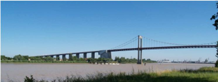
Il forme un ouvrage spectaculaire par son tablier suspendu à 53 mètres au dessus du fleuve, entre deux énormes piles, sur un longueur totale de 1767 mètres et une surface utile de 13600 mètres carré.
